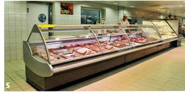
1 2 Gros plan sur le système U-Turn de l'installation Sorelait à la Réunion et ses condenseurs à air. 3 La centrale frigorifique en cascade au Super U Étang salé à la Réunion. 4 Le réseau frigorifique. 5 Les meubles froid positifs sont alimentés en eau glycolée.
