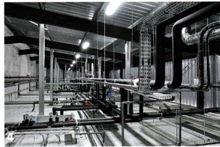
1 2 Gros plan sur le système U-Turn de l'installation Sorelait à la Réunion et ses condenseurs à air. 3 La centrale frigorifique en cascade au Super U Étang salé à la Réunion. 4 Le réseau frigorifique. 5 Les meubles froid positifs sont alimentés en eau glycolée.
