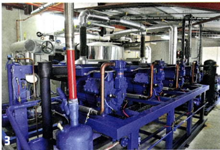
1 2 Gros plan sur le système U-Turn de l'installation Sorelait à la Réunion et ses condenseurs à air. 3 La centrale frigorifique en cascade au Super U Étang salé à la Réunion. 4 Le réseau frigorifique. 5 Les meubles froid positifs sont alimentés en eau glycolée.
