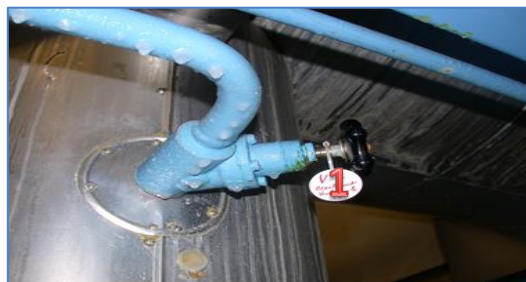
Vanne V1 [bas de la bouteille BP]
