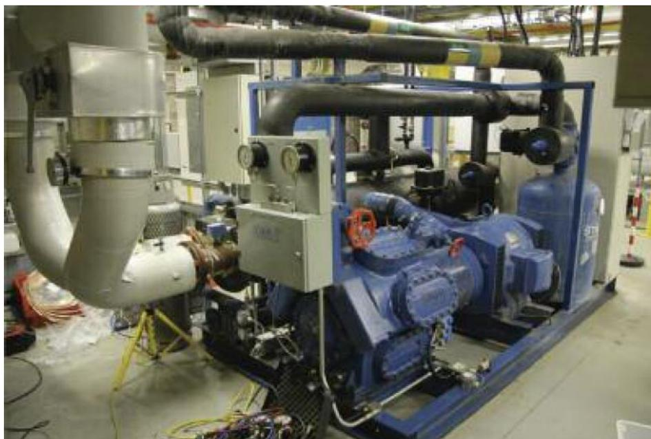
Suite au succès de la conversion des deux refroidisseurs noyés « Dunham Bush PCX 700 » sur le site de EDF Energy de « Barnwood » à Gloucester Angleterre, d'autres travaux de rénovation ont été menés sur les chillers à évaporateurs noyés à cycle thermo-siphon de la société Star Refrigeration.
